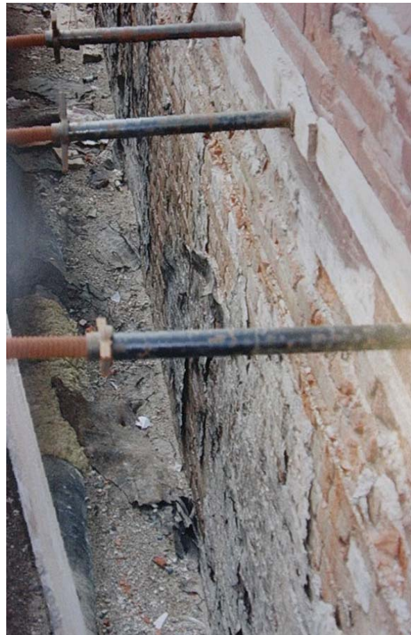
Deutlich erkennbar die mehrlagige Abdichtung
